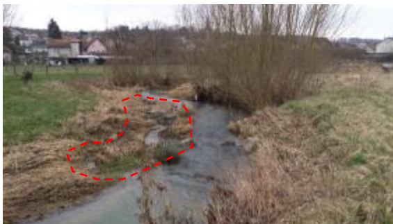
1 er site de dépôt vue amont
