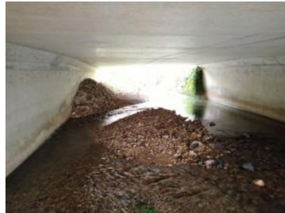
Vue aval : graviers et galets
