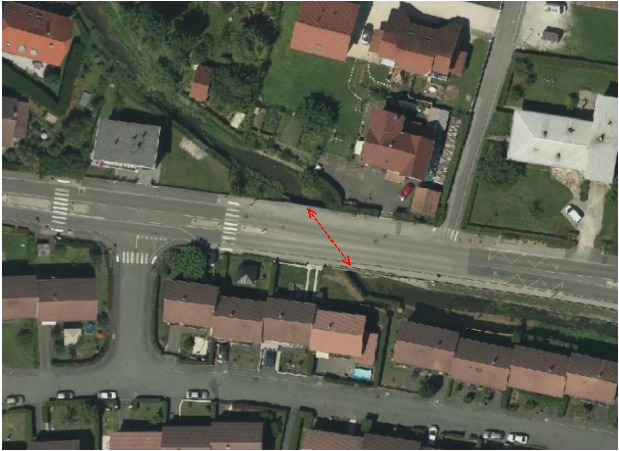
Figure 3 : Site de l'arasement de l'atterrissage
