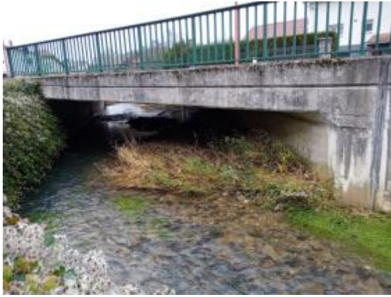
Vue amont atterrissement
